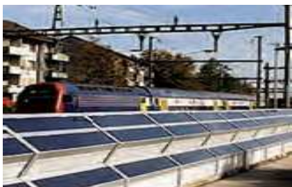
Fig.1 - Barriera antirumore, Svizzera
